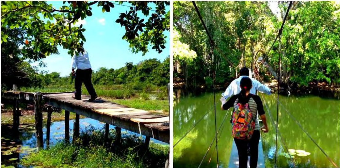
Figura 10. Socio guía caminando por el puente que sirve como camino de acceso hacia los cenotes (imagen izquierda). Guía caminando delante de una visitante del Centro sobre el puente colgante que atraviesa el Río Verde (imagen derecha).
