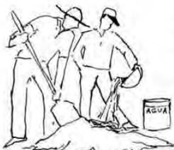
2. Preparación de la mezcla. En una superficie plana colocar 5 cubos de polvo de piedra, 1/2 cubeta de cal y 1/2 cubeta de cemento. Mientras se revuelve, agregar agua de poco en poco, para evitar excesos. Continuar hasta obtener una mezcla uniforme.
