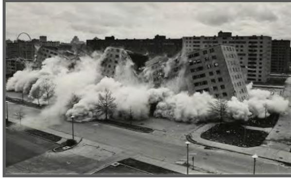
**Figura 6.** Demolición del edificio habitacional Pruitt-Igoe.
