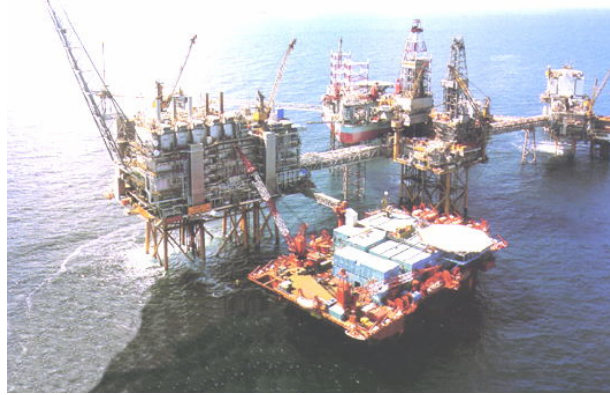
Figura 4-8. Fotografía de una plataforma petrolera
