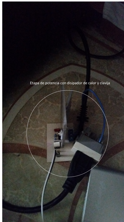
Figura 6.18: Etapa de potencia para motor de corriente alterna
