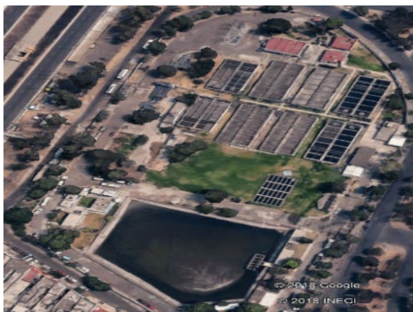
Figura 6.1. Imagen área de la PTAR SJA
