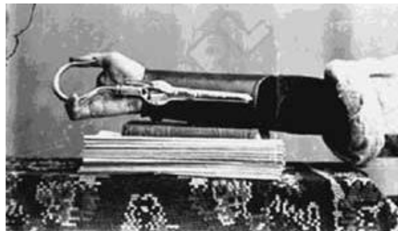
Figura 4. Prótesis de mano con pulgar móvil y gancho dividido sagitalmente
