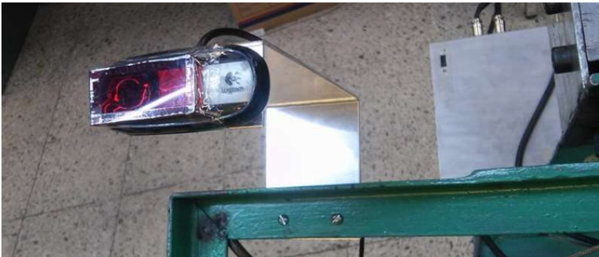
Fig. 3.7 Cámara Web sujeta a la parte superior izquierda del seguidor solar
