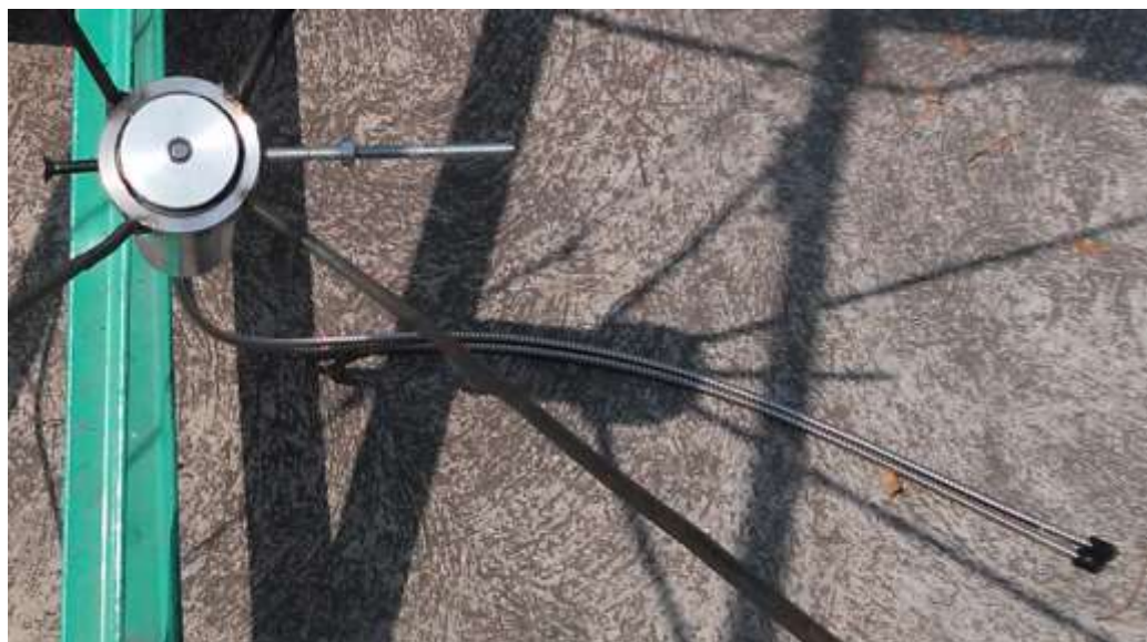
Fig. 4.8 Mecanismos de Sujeción de la fibra óptica
