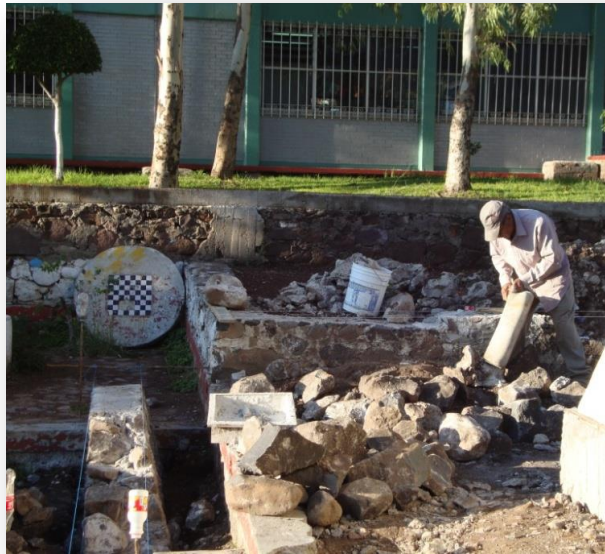
Fotografía 5. Mejoramiento de las instalaciones de la Secundaria Mariano Escobedo
