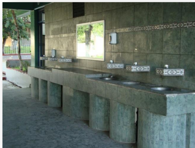
Fotografía 7. Baños de la Secundaria Mariano Escobedo
