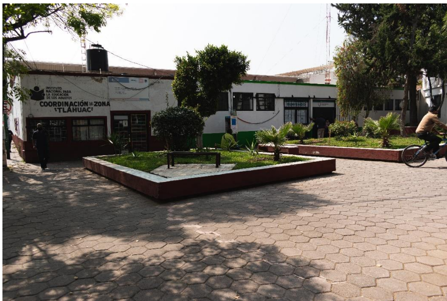
Figura 45. INEA-Tláhuac y Centro de Finanzas, Tenencias y Control Vehicular
