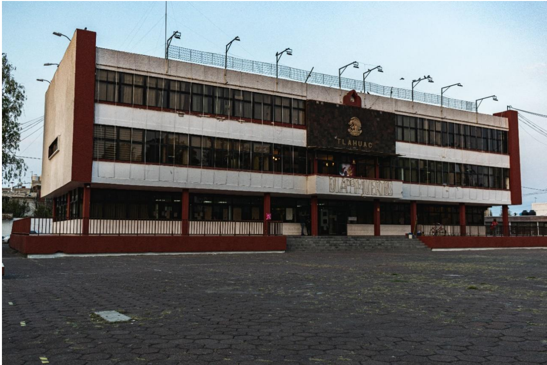
Figura 8. Edificio principal de la alcaldía Tláhuac
