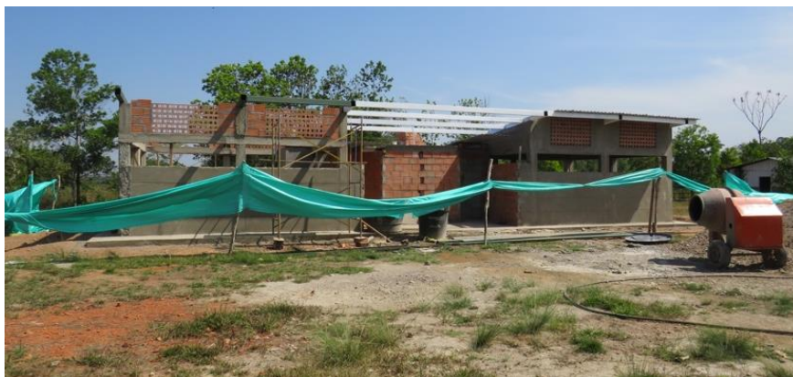
Fotografía 6: Construcción del internado en La Planicie. Fuente propia, tomada Feb/2019
