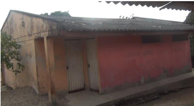
Fotografía 24: Parte frontal de la biblioteca. IE La Ribera. Feb/2019. Fuente: Propia
