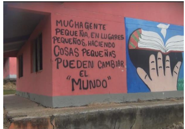
Fotografía 25: Muro trasero de la biblioteca. IE La Ribera. Feb/2019. Fuente: Propia
