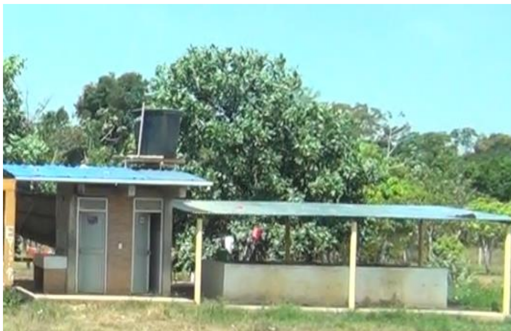
Fotografía 20: Área de sanitarios y lavado, IE La Planicie. Fuente: Propia
