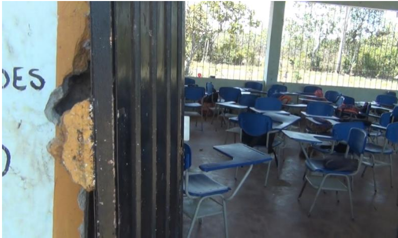
Fotografía 21: Aula de bachillerato. IE La Planicie. Fuente Propia
