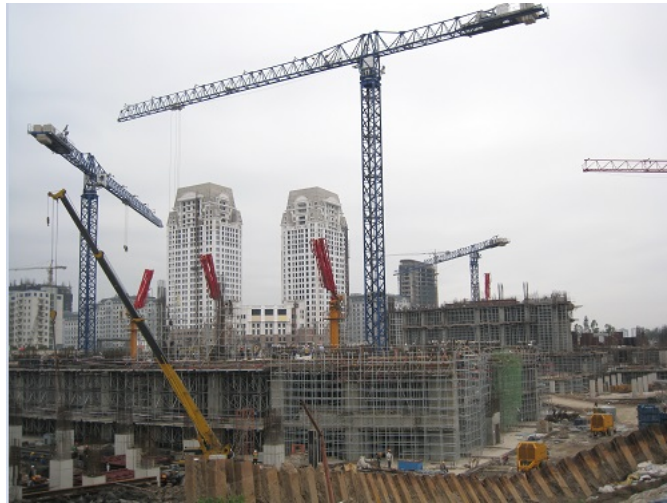
Figura 1.3: Grúas Torre en obra.
