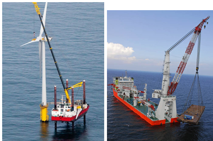
Figura 1.2: Grúas offshore manejando cargas.
