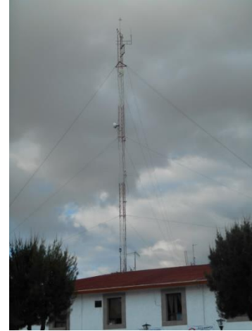
Figura 1. 30 Ejemplo de una torre arriostrada
