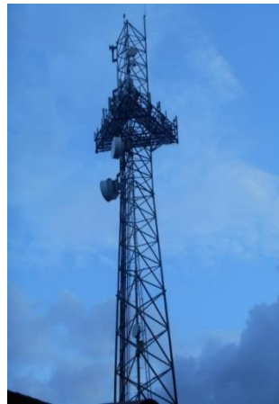
Figura 1. 31 Ejemplo de una torre auto-soportada
