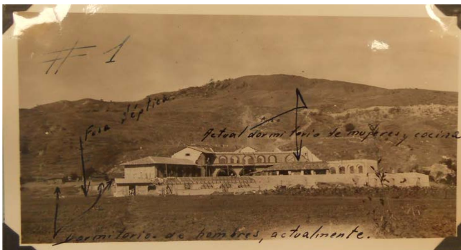
Construcción Edificio Escuela Normal Rural de Ayotzinapa, 1933. Fuente: AGN, AHSEP, c. 33273, exp. 26, f. 9.
