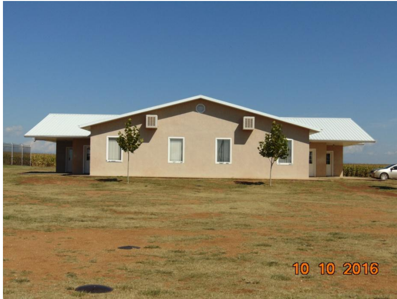
Foto 5. Construcción 2 - Edificio con cuatro aulas, territorio escolar del campo 305 En la parte izquierda de la construcción está la entrada a dos aulas y en la parte derecha, la entrada de las otras dos.
