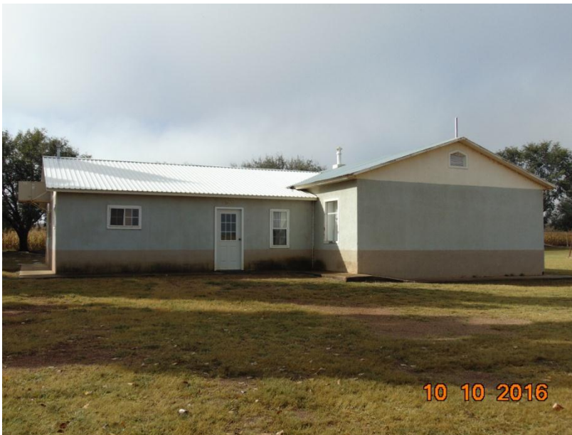
Foto 12. Construcción 2 – Territorio escolar del campo 302 En esta construcción hay dos aulas, en la foto se observa la entrada para una y del otro lado está la entrada para la segunda.
