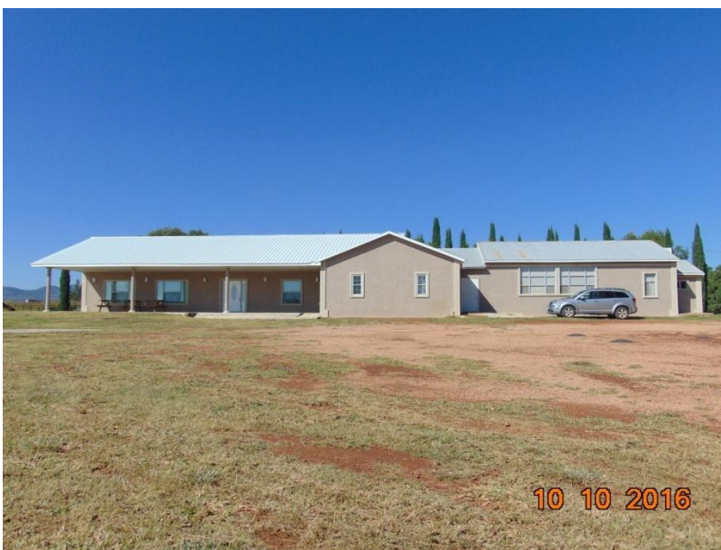
Foto 14. Construcción, territorio escolar del campo 304 En esta construcción hay dos aulas
