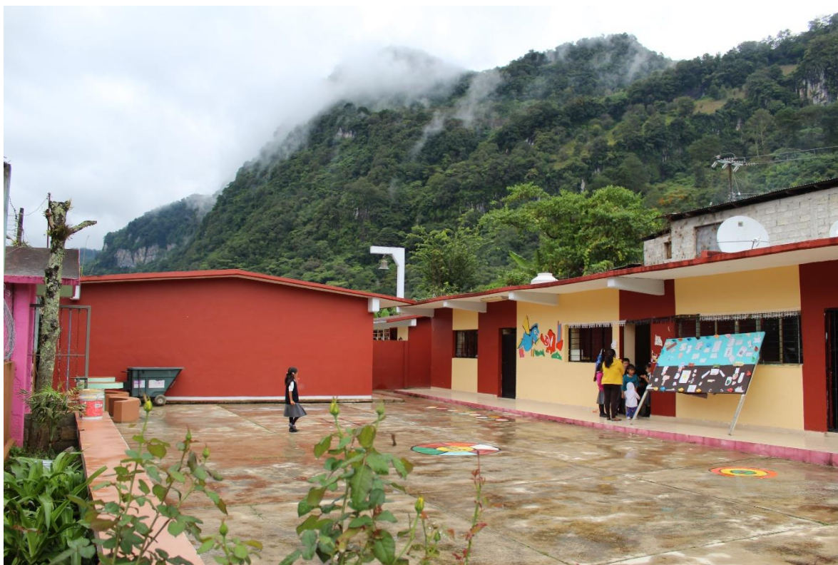
Fotografía 2. Edificio A de la escuela primaria Francisco Villa. Fotografía de la autora, 2018.
