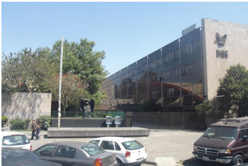
Figura 3.8. Edificio original de la Preparatoria Técnica Piloto (Hasta 2011, Hospital General de Zona N° 27 Dr. Alfredo Badallo). En el reflejo de los cristales del edificio se observa el antiguo auditorio. Cortesía del M. en C. Gumersindo David Fariña López, (1996).
