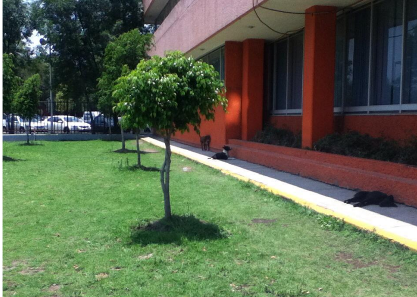
Figura 5.34 Lateral posterior de las instalaciones de Instalaciones y Mantenimiento Eléctrico.
