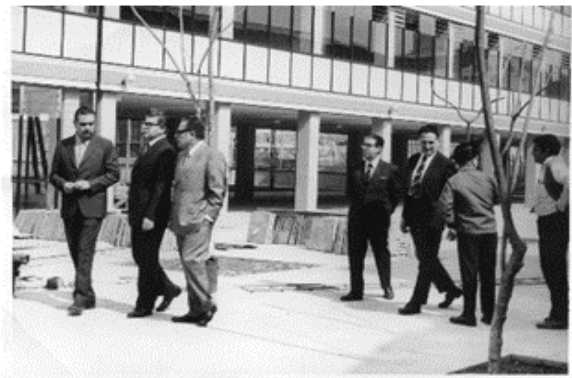
Figura 3.13 Visita a las obras de construcción (1969) en Iztapalapa. (De izquierda a derecha) Dr. Eusebio Mendoza Ávila, Dr. Héctor Mayagoitia Domínguez, Ing. Víctor Bravo Ahuja, secretario de Educación pública, Cp. Marcelo Heding García y el Ing. Manuel Zorrilla Carcaño. Archivo del Decanato.
