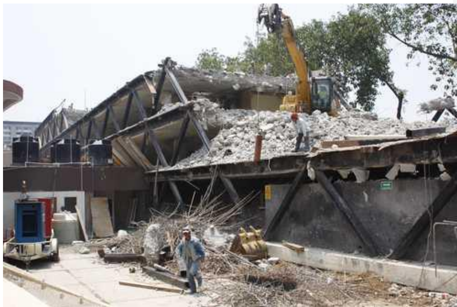
Figura 3.18 Trabajos de demolición del antiguo edificio de la Voca 7 en la Plaza de las Tres Culturas. 79
