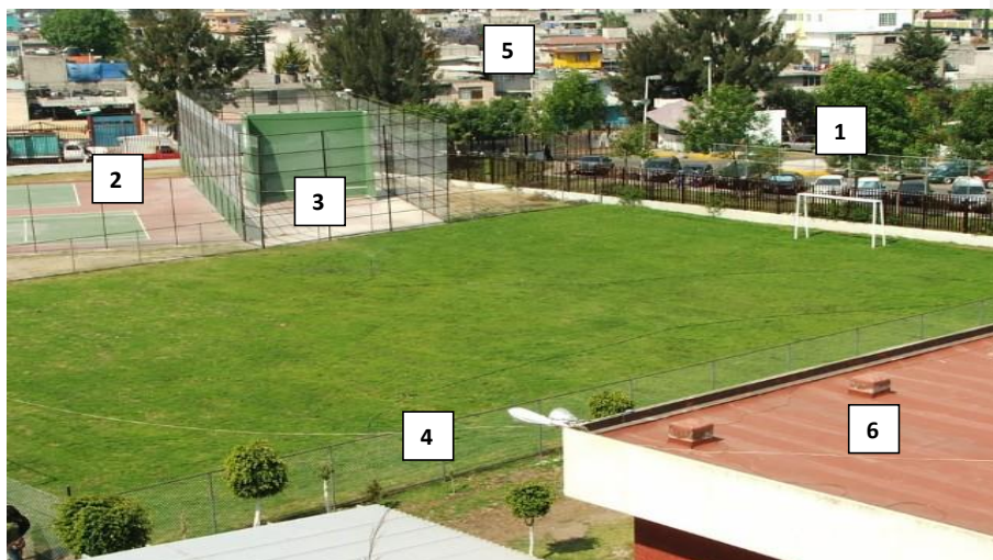
Figura 5.2 Lado poniente del plantel. Estacionamiento actual [1], cancha de tenis [2], frontón [3] cancha libre para futbol y otros eventos [4], parte de colonia Santa María Azahuacan [5], taller de Instalaciones y Mantenimiento Eléctrico [6]
