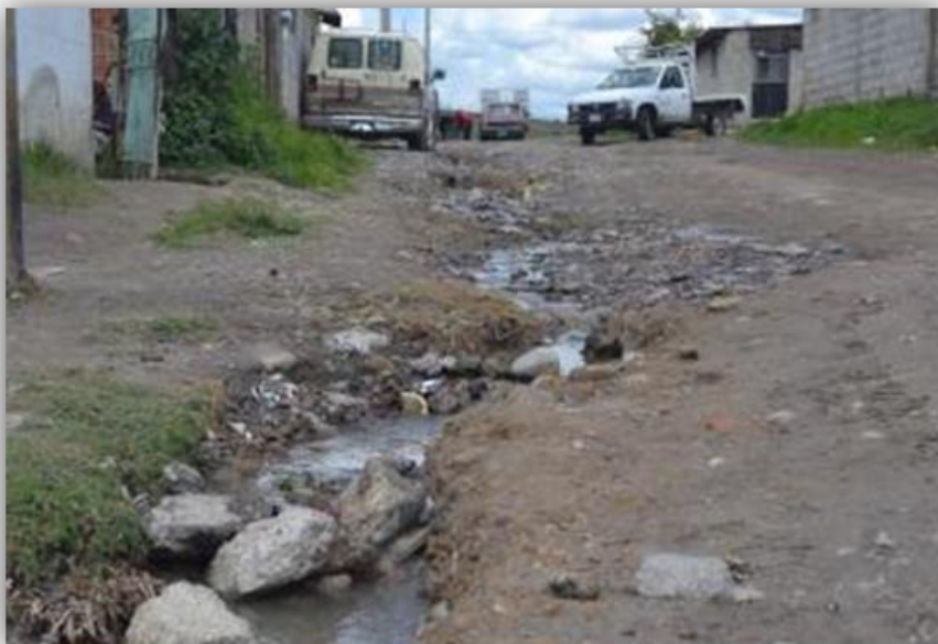
Figura 5.14 Cuando llueve de manera intensa o durante un largo periodo el agua se queda estancada en este sitio debió a las irregularidades del camino, lo que provoca malos olores y que surjan moscos de estas aguas, tengo que cruzar por este lugar para llegar a mi casa y al caminar por aquí, el olor es muy desagradable y termino lleno de
