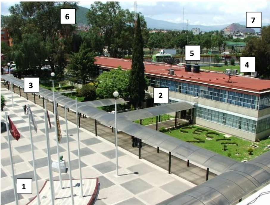
Figura 5.1 Vista parcial de la explanada [1] y edificio de gobierno [2] que integra la biblioteca, aula siglo XXI y auditorio del plantel, pasillos de ingreso [3], parte de la calzada Ermita Iztapalapa [4] y parte de la cancha de futbol americano [5]. A lo lejos la sierra de Santa Catarina [6] y el Cerro de la Estrella [7].
