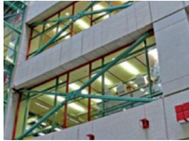
Figura 1.2: Control pasivo usado en una estructura tipo edificio [40].
