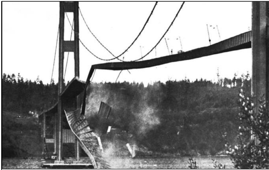
Fig. 4 Puente de Tacoma-Narrows durante vibración [1].
