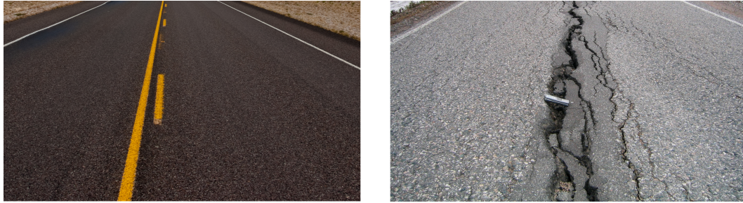
Fig. 1.22: Diferencia entre una carretera de asfalto en buenas condiciones y una en mal estado(fracturada)[55, 56].
