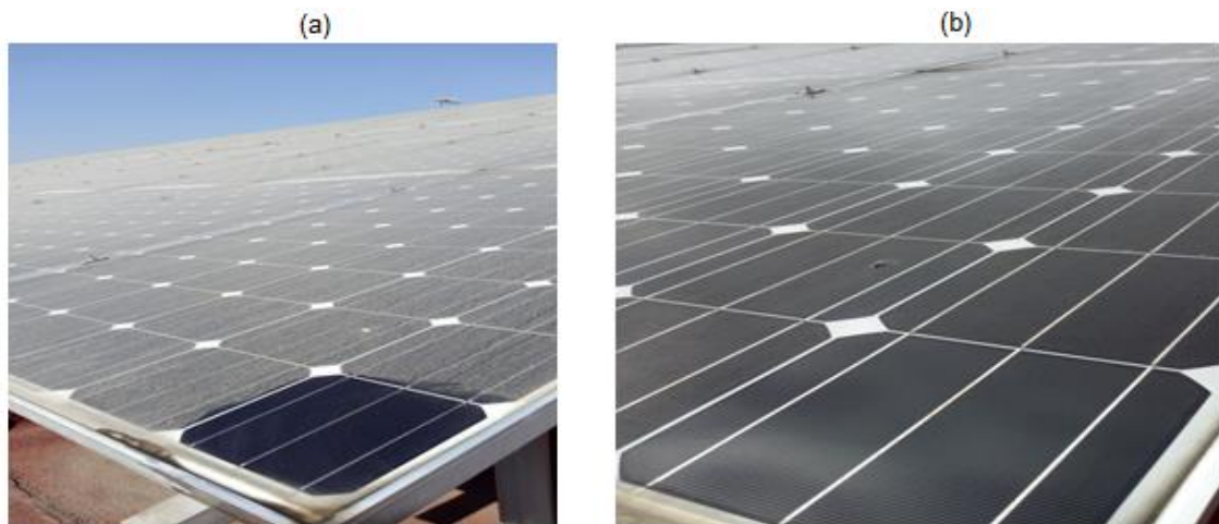
Figura 49 Aspecto de un efecto de suciedad del Arreglo Fotovoltaico. a) Antes y b) Después de la lluvia. el 18 de enero de 2020.
