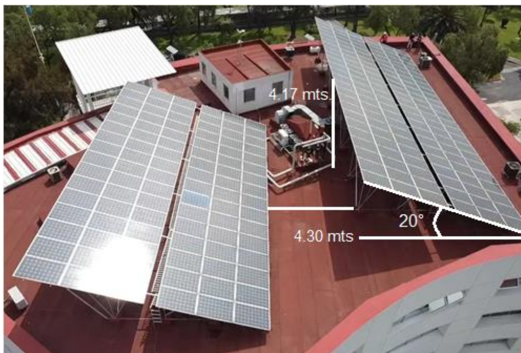
Figura 39 Medición de Distancia entre filas y altura de la estructura metálica del SFV.
