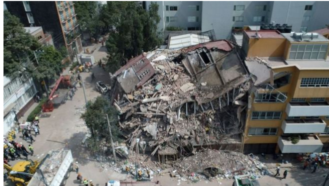
Figura 1.1: Edificio colapsado durante el sismo del 2017 en la Ciudad de México 1
