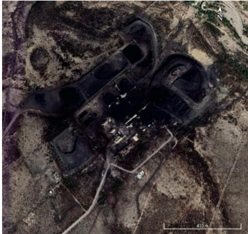
Figura 3. Imagen satelital del área de estudio localizada en una planta de beneficio de carbón ubicada en el municipio de San Juan de Sabinas, Coahuila de Zaragoza.
