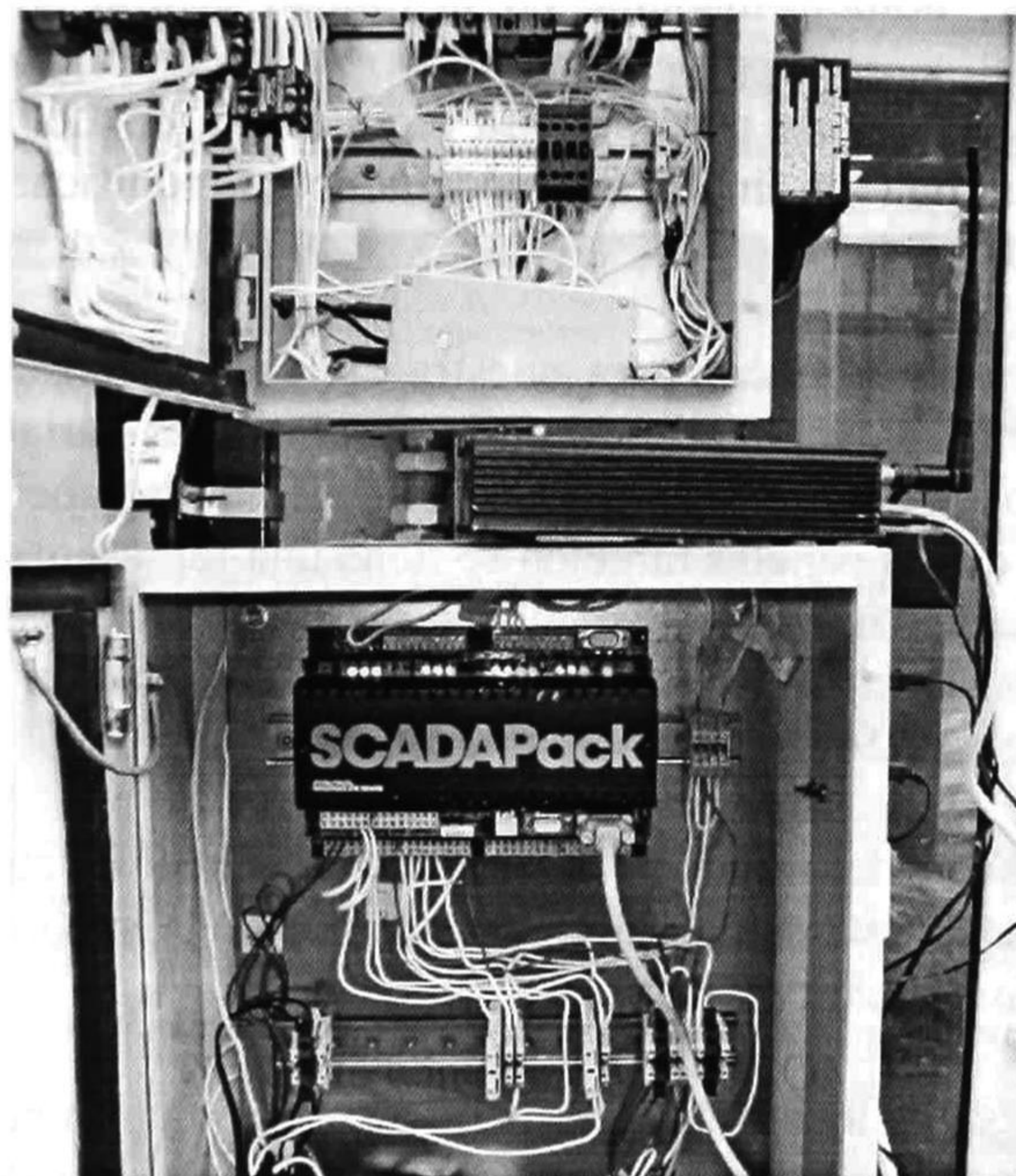
Figura. 5.8 Sistema SCADA PACK
