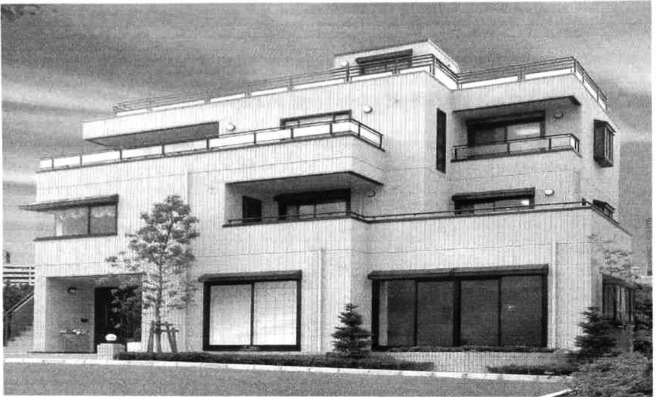
Figura (5) Multifamiliar tipo en las que se pueden emplear los materiales desarrollados. Laminados exteriores de cemento Pórtland reforzados con fibras de vidrio tipo "e".
