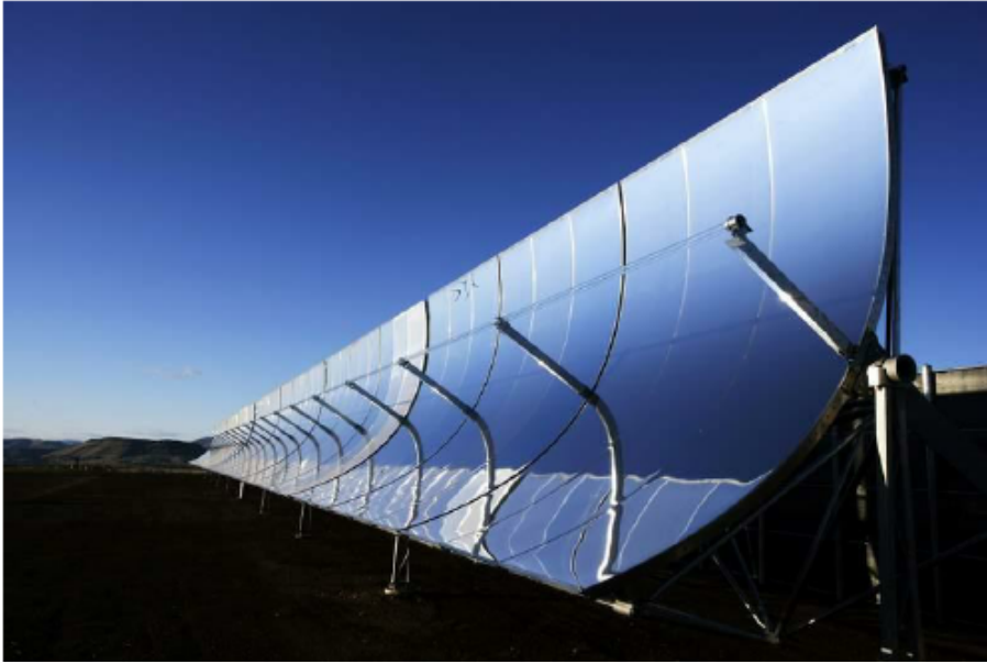
Figura 1: Sistema Termo-solar de canal parabólico para la conversión de energía solar en térmica [17]
