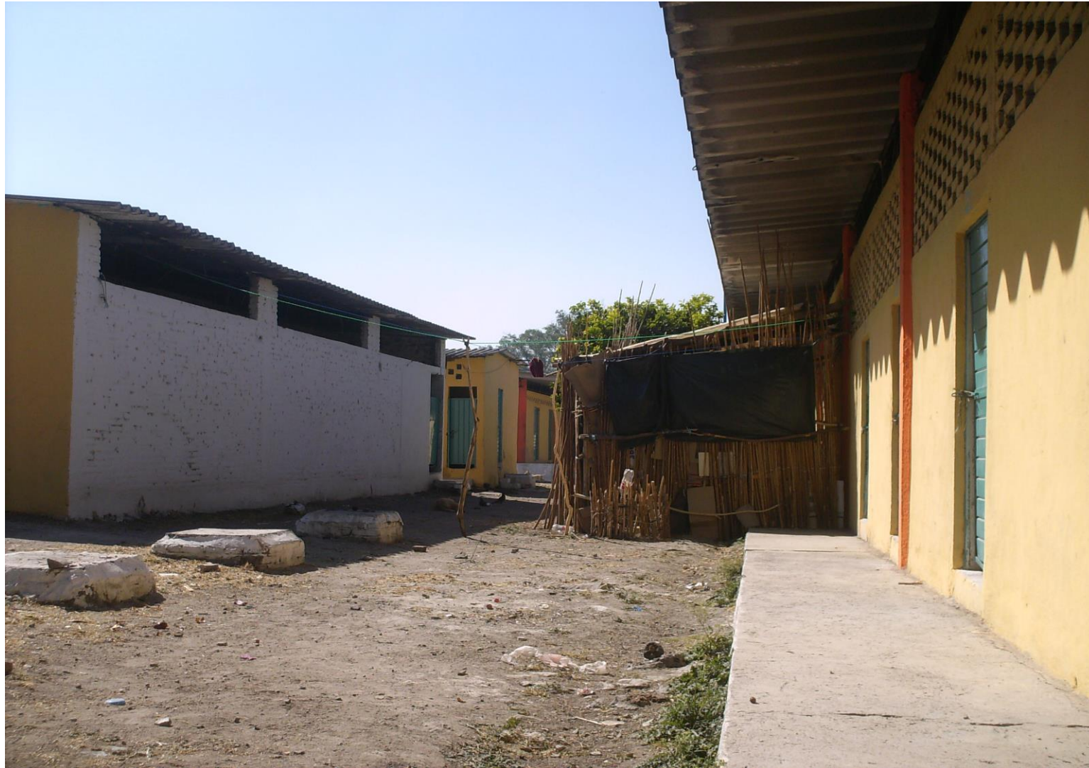
Fotografía 7: Construcción de carrizo y madera condicionada como cocina.
