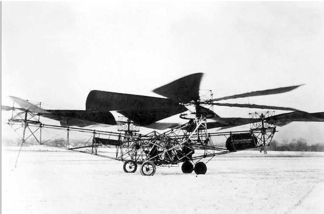
Figura 2.1: El helicóptero de cuatro rotores de Bothezat.
