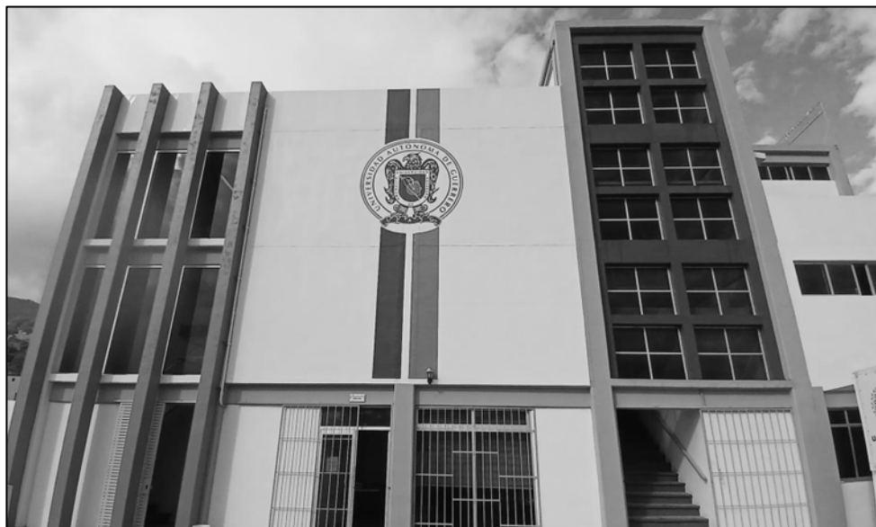
Figura 4.2: Vista general de la CUI
