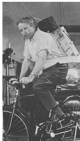
Fig. 2. 5 Norman J. Holter con su radio-electrocardiógrafo de registro original de 38 kg en 1947 [35].
