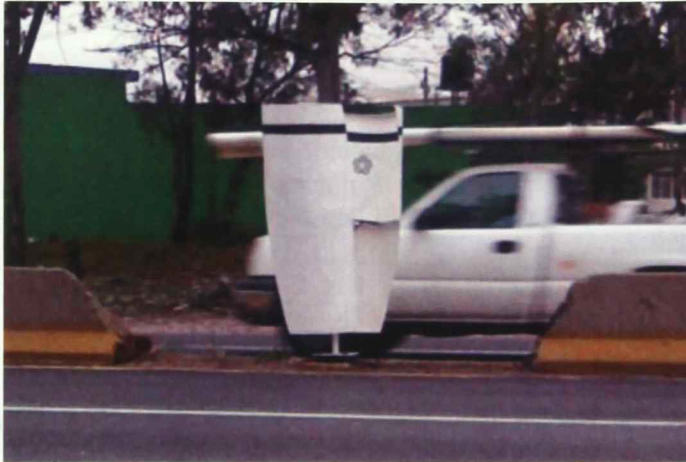
Fig. 11-5. Aerogenerador instalado en el periférico.
