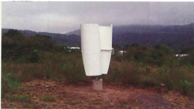
Fig. 10-12. Aerogenerador instalado en el Cinvestav.
