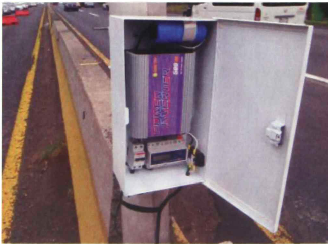
Fig. 11-6. Inversor instalado en el periférico.
