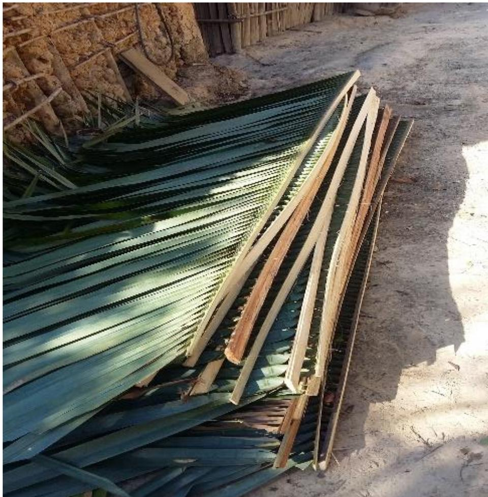
Figura 4. 4. Trozos de palma ya cortadas a la medida necesaria para hacer el techo
