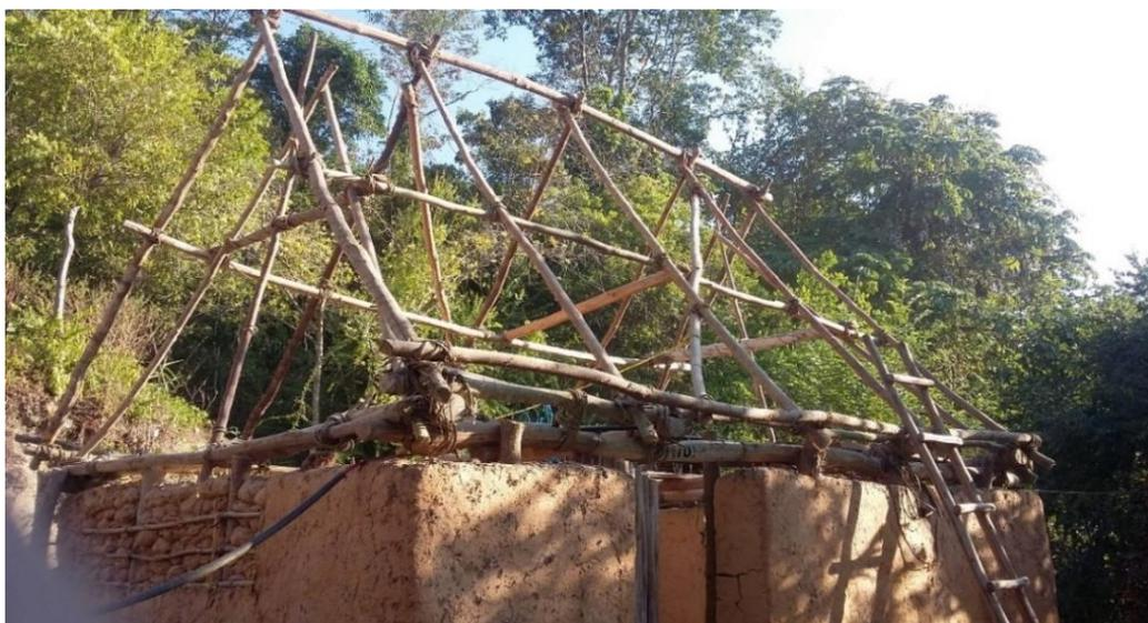
Figura 4. 20. Armazón del techo de una casa de palma<sup>42</sup>
