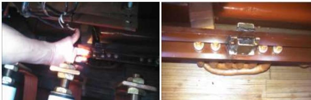
Figura 5.1.4.4. Imágenes de la presencia de carbonización por punto caliente dentro del transformador
